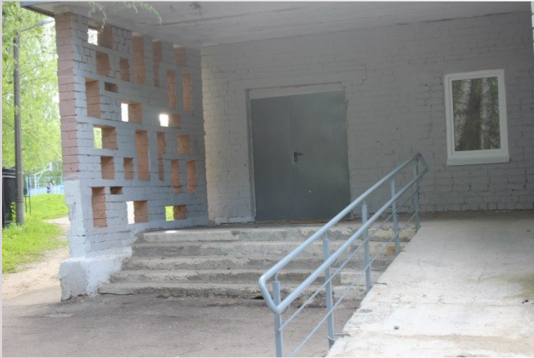
Вход в здание школы (пандус). ДПВ*
